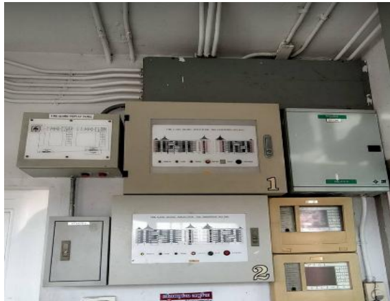
รูปที่ 1 ตู้ควบคุมระบบตรวจจับและแจ้งเหตุเพลิงไหม้
