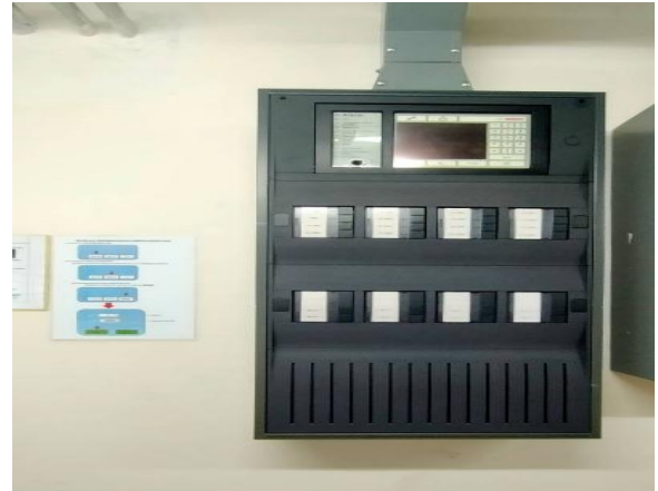
รูปที่ 1 ตู้ควบคุมระบบตรวจจับและแจ้งเหตุเพลิงไหม้
