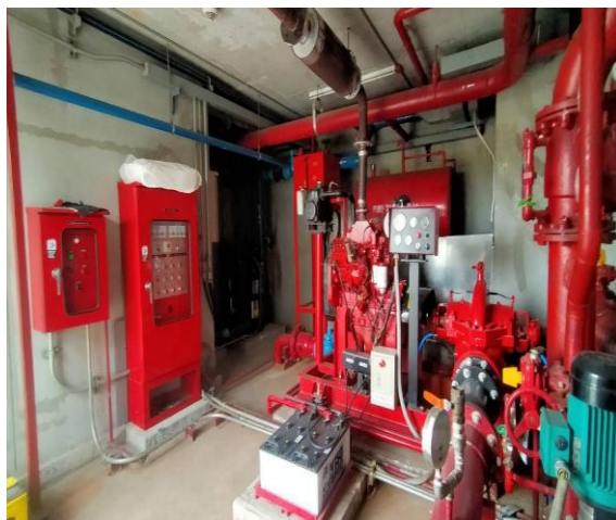
รูปที่ 4 ปั้มน้ำดับเพลิง
