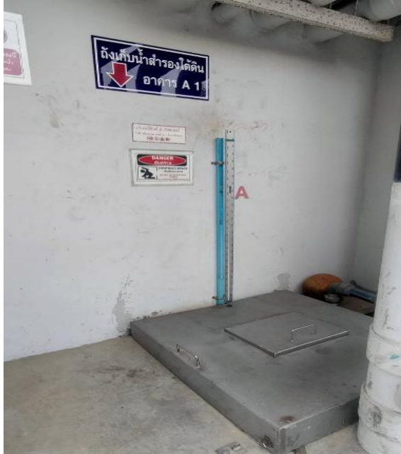
รูปที่ 1 ถังเก็บน้ำสำรองใต้ดินอาคาร A
